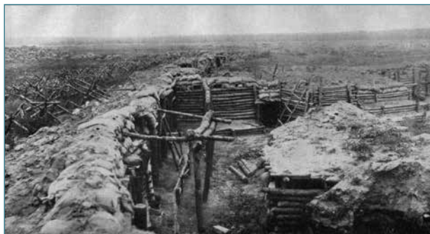
Ryc. 8. Opuszczona rosyjska pozycja w rejonie Mogił (w okolicy wsi Joachimów-Mogiły, nazwa współczesna) z widocznym przed okopem ciągiem „kozłów hiszpańskich”. Zdjęcie wykonane latem 1915 r. i zamieszczone w albumie XXV Korpusu Rezerwowego ( Das XXV Reservekorps im Felde 1914-1916 , 1917), którego oddziały walczyły przez siedem miesięcy właśnie w rejonie Mogił (Zdjęcie z kolekcji prywatnej J. Czarneckiego).
